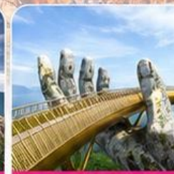
สะพานมือสีทอง
