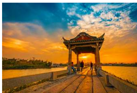
สะพานอันผิง
